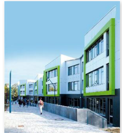
Neubau: GHS in Griesheim
